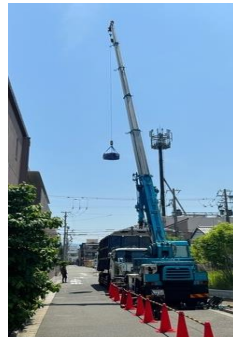
室外機 搬入搬出 (レッカー作業)
