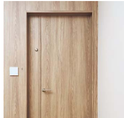
電気錠を取り付けることができる加工を施した子壁を枠内に設置することで電気錠(Uオーダー)が対応可能になります。
