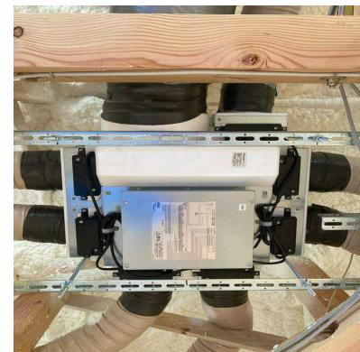
2階 VAVチャンバー取付
