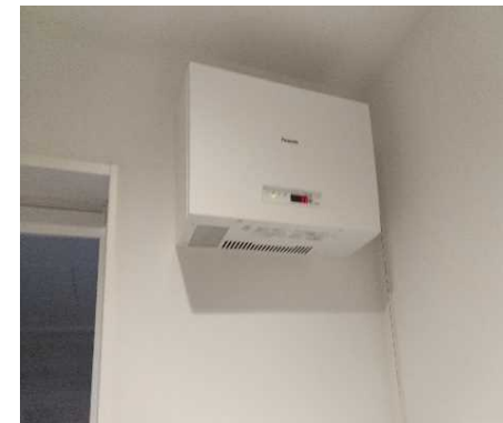
パワーコンディショナー設置
