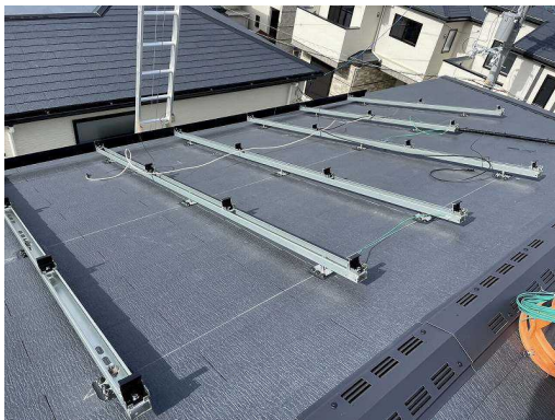
パネル設置前(架台取付)
