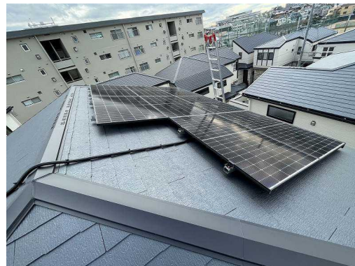
太陽光パネル設置
